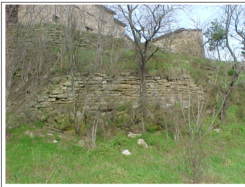
Fotogramma 5. Muro sottostante Cà di Co.
