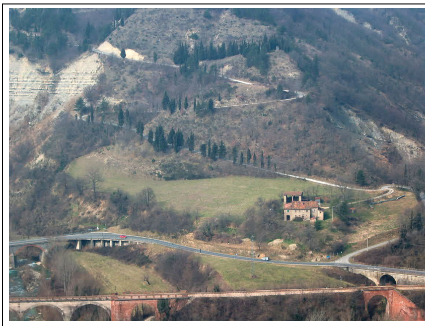
Fotogramma 2. Vista panoramica del sito interessato da lavori di rettifica stradale.
