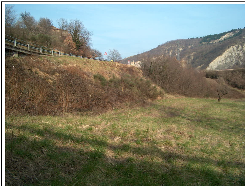
Fotogramma 11. Terrazzo del Fiume Lamone sottostante il tratto stradale interessato da rettifica.
